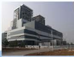
神华富平2*660MW电厂降噪治理项目
