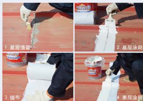
金属屋面搭接处施工流程
