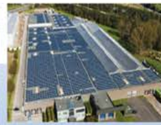
中煤大海则屋面光伏项目
