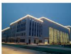
北京大兴机场项目
