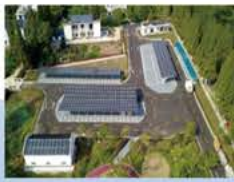
BIPV光伏车棚项目
